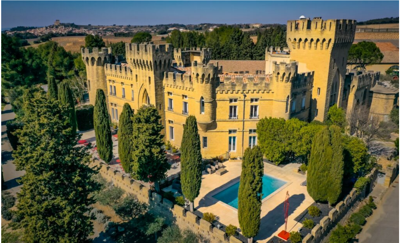
Le Château des Fines Roches
