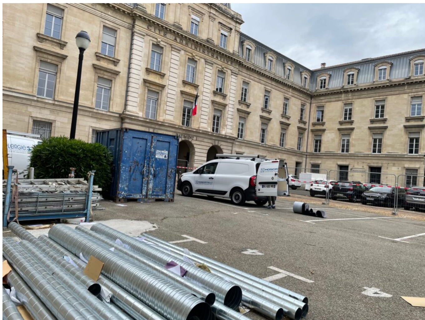
Le parking accueille véhicules d'entreprise, matériaux et bennes
