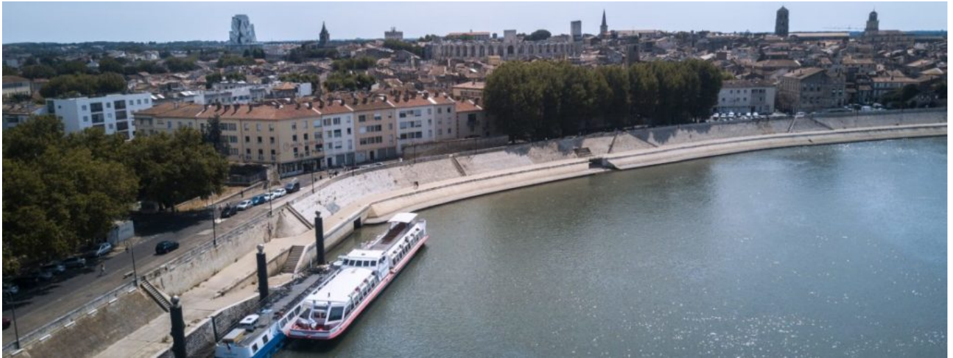
Photo: Grands bateaux de Provence
