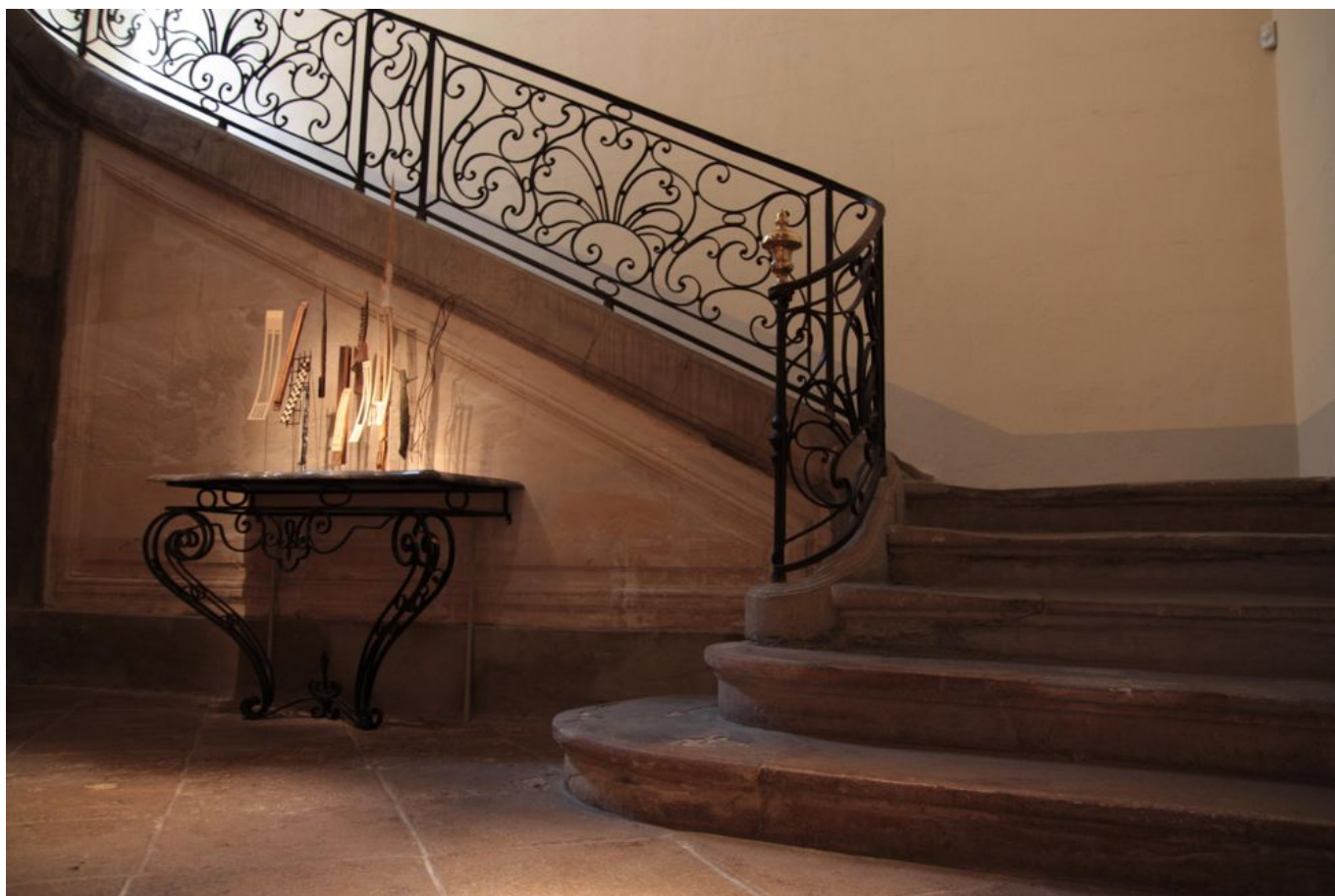
Les escaliers du centre seront nettoyées et restaurées © DR
